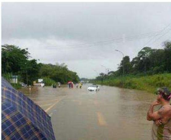
Inondation de la RNI au droit de Soula 1 le 15 mai 2013 (France Guyane), photo issue de l'étude d'impact AGIR, mars 2018.
