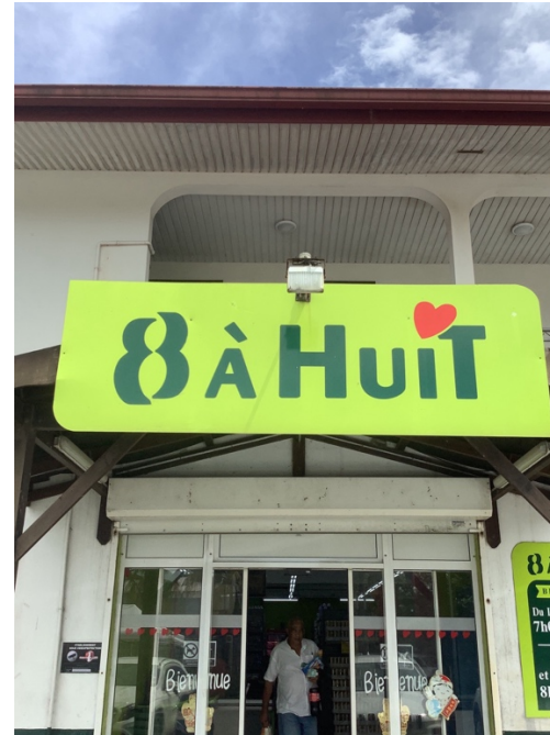
Enseigne lumineuse éclairée par projection (spot)
