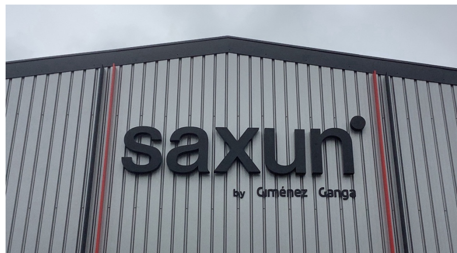
Enseigne parallèle au mur en lettres découpées
